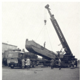
Het laden van baggermolen Laden von baggermaterial Loading a cutterbarge
