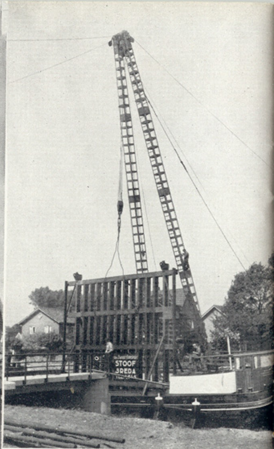
Het plaatsen van de val.
