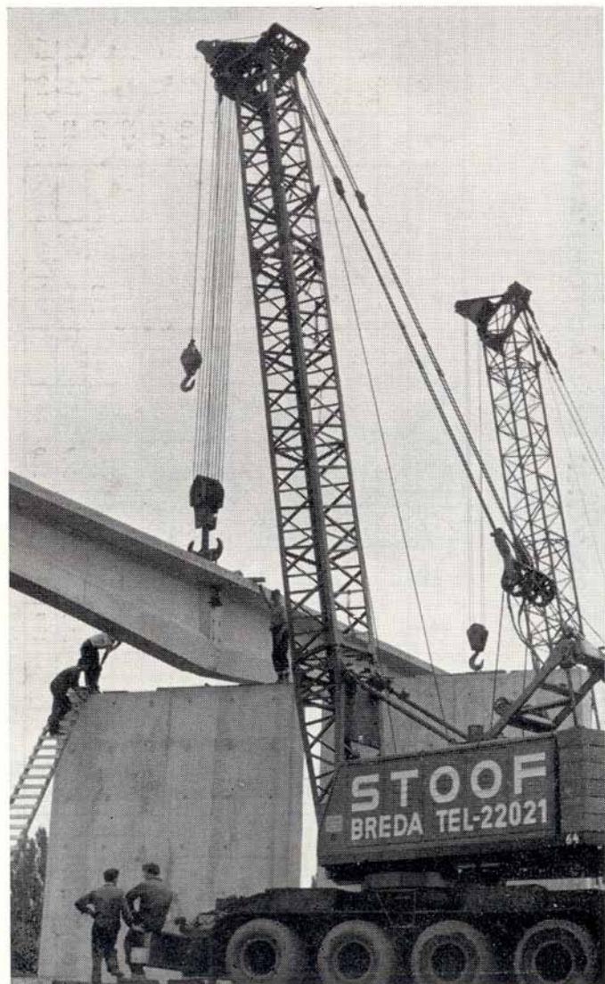
Het lossen van voorgespannen-beton viaductdelen door middel van 2 mobiele kranen.
