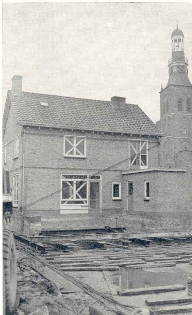
Slede-transport van een compleet woonhuis met schuur.
